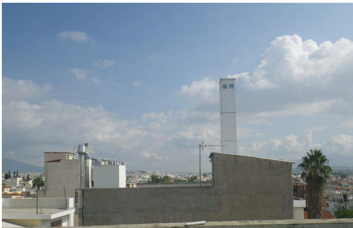
Φωτογραφία I.1: Άποψη του σταθμού βάσης κινητής τηλεφωνίας της εταιρείας VODAFONE-PANAFON ΑΕΕΤ. επί της οδού Κρυσταλλοπηγής 49Α, στο Δήμο Ιλίου Αττικής
