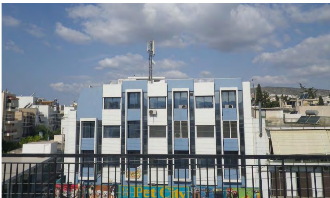
Φωτογραφία ΚΑ.2: Άποψη του σταθμού βάσης κινητής τηλεφωνίας της εταιρείας COSMOTE Α.Ε. επί της Λ. Θηβών 281, στο Δήμο Ιλίου Αττικής
