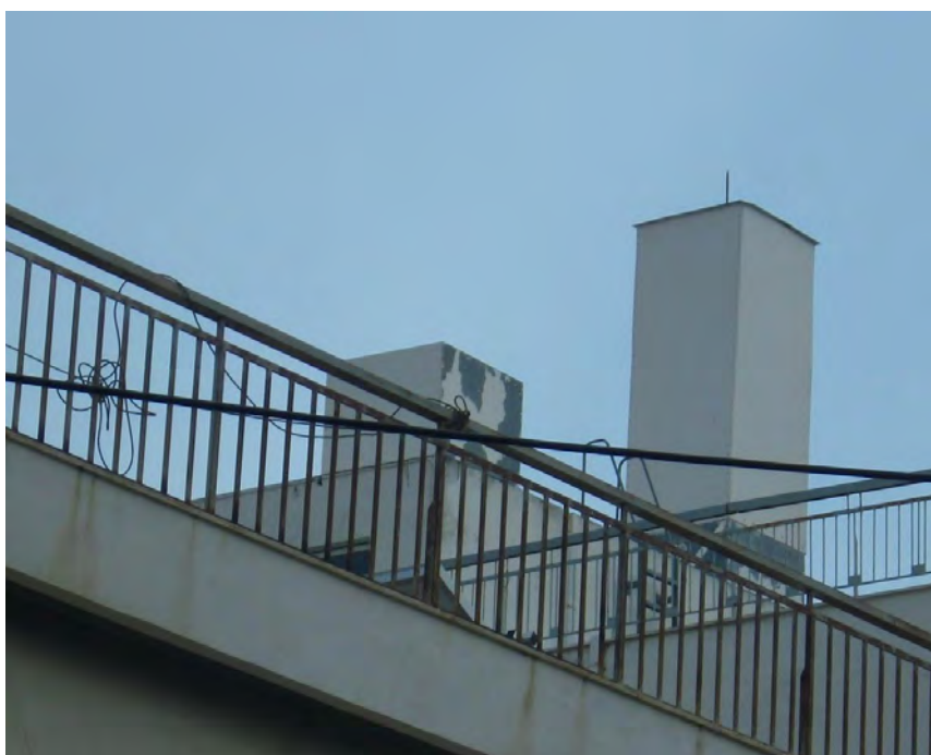
Φωτογραφία ΣΤ.1: Άποψη του σταθμού βάσης κινητής τηλεφωνίας της εταιρείας WIND ΕΛΛΑΣ ΤΗΛΕΠΙΚΟΙΝΩΝΙΕΣ Α.Ε.Β.Ε. επί της οδού Φιλοκτήτου 84, στο Δήμο Ιλίου Αττικής
