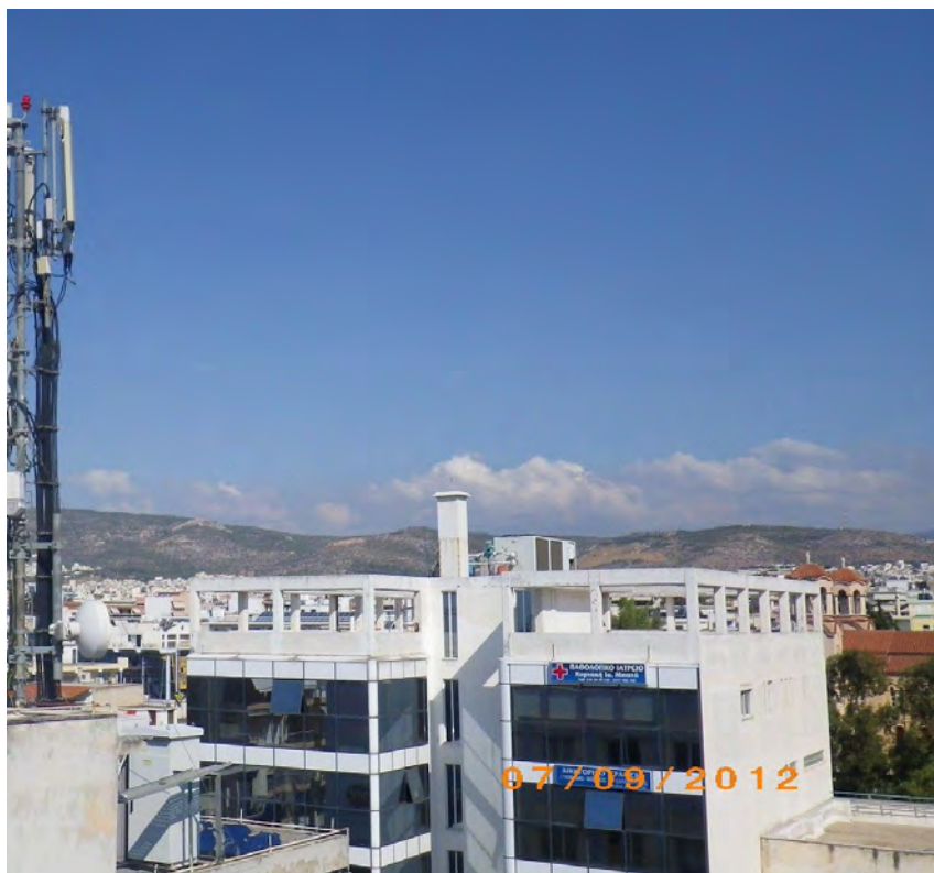
Φωτογραφία Θ.3: Άποψη του σταθμού βάσης κινητής τηλεφωνίας της εταιρείας VODAFONE-PANAFON Α.Ε.Ε.Τ. επί της συμβολής των οδών Πρωτεσιλάου & Πριάμου, στο Δήμο Ιλίου Αττικής
