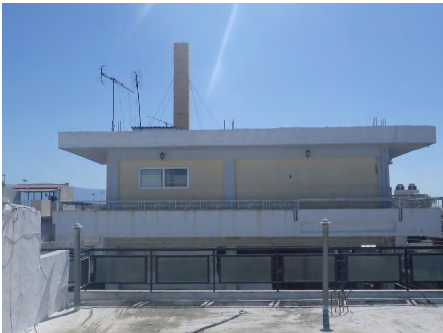
Φωτογραφία ΙΗ.2: Άποψη του σταθμού βάσης κινητής τηλεφωνίας της εταιρείας COSMOTE Α.Ε επί της συμβολής των οδών Παλατιανής και Βυζαντίου, στο Δήμο Ιλίου Αττικής
