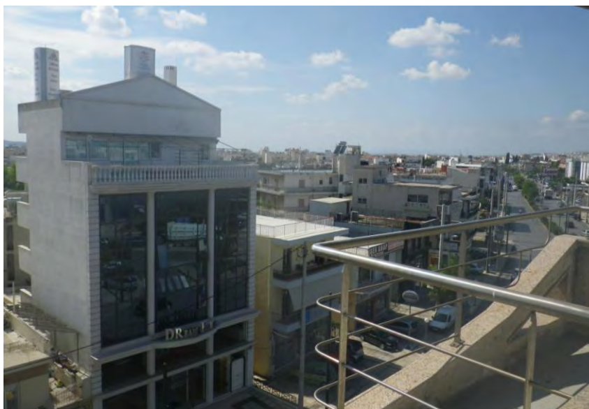
Φωτογραφία Η.1: Άποψη των σταθμών βάσης κινητής τηλεφωνίας των εταιρειών COSMOTE Α.Ε και VODAFONE PANAFON ΑΕΕΤ επί της συμβολής των οδών Ιδομενέως 113 και Θηβών, στο Δήμο Ιλίου Αττικής
