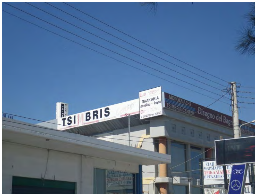
Φωτογραφία ΙΓ.1: Αποψη του σταθμού βάσης κινητής τηλεφωνίας της εταιρείας WIND ΕΛΛΑΣ ΑΕΒΕ επί της Λ. Χασιάς 133, στο Δήμο Ιλίου Αττικής
