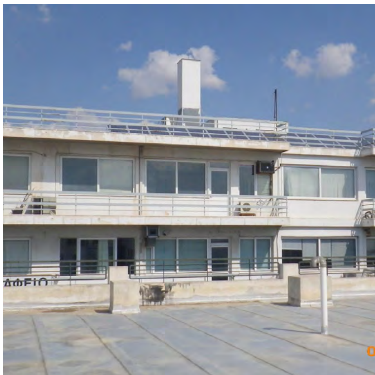
Φωτογραφία ΣΤ.2: Άποψη του σταθμού βάσης κινητής τηλεφωνίας της εταιρείας WIND ΕΛΛΑΣ ΤΗΛΕΠΙΚΟΙΝΩΝΙΕΣ Α.Ε.Β.Ε. επί της οδού Φιλοκτήτου 84 στο Δήμο Ιλίου του Νομού Αττικής
