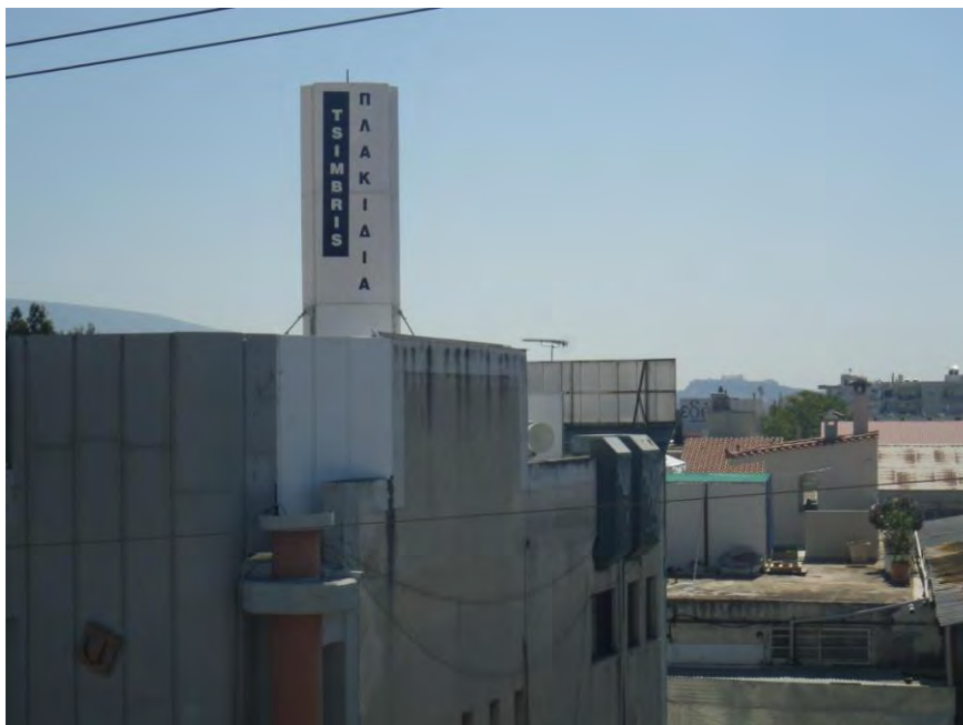
Φωτογραφία ΠΓ.2: Άποψη του σταθμού βάσης κινητής τηλεφωνίας της εταιρείας WIND ΕΛΛΑΣ ΑΕΒΕ επί της Λ. Χασιάς 133, στο Δήμο Ιλίου Αττικής
