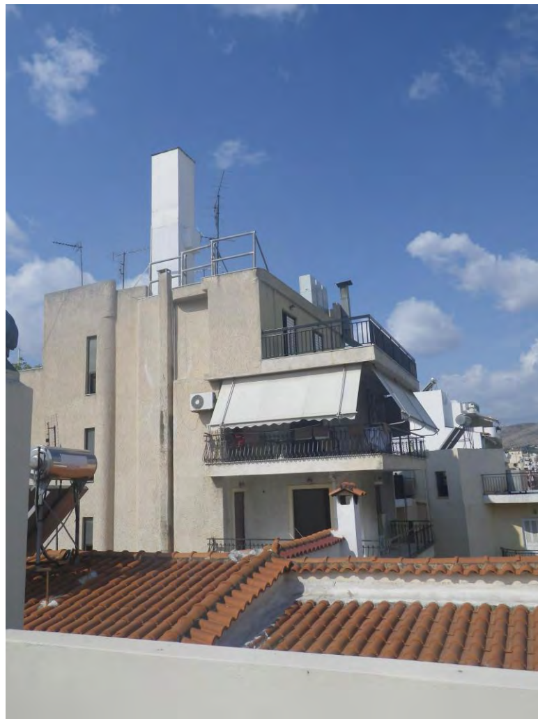
Φωτογραφία ΚΓ.1: Άποψη του σταθμού βάσης κινητής τηλεφωνίας της εταιρείας WIND ΕΛΛΑΣ ΑΕΒΕ επί των οδών Ωρωπού 11 & Αγ. Γεωργίου 18, στο Δήμο Ιλίου Αττικής
